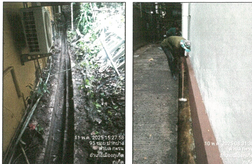
รูปภาพที่ 2.7 การขุดลอกตะกอน
